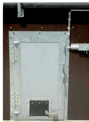
Auslauftür selbstschließend mit Ferkelauslaufklappe
