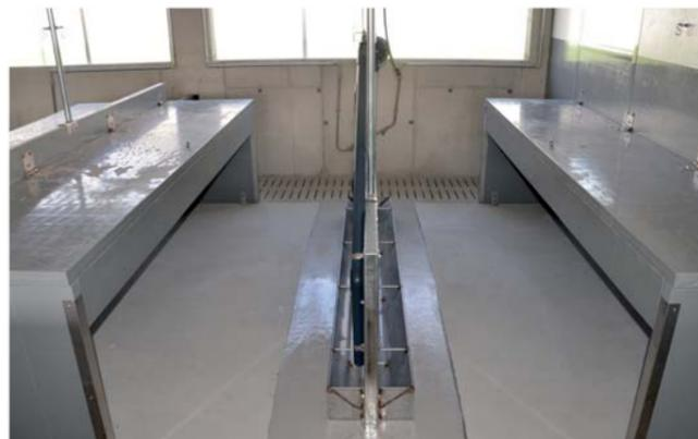
System mit einer Kleinklimazone – der Liegebereich kann mit einer Bodenheizung ausgestattet werden
