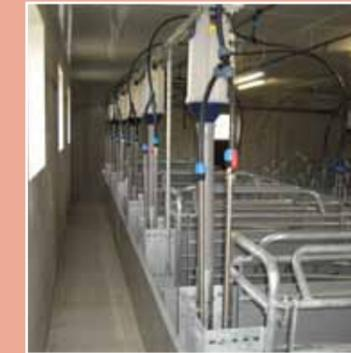
Bediengang mit Unterflurzuluft
