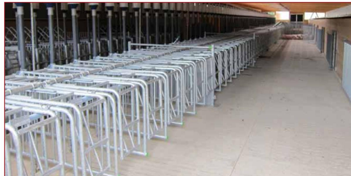
SFK MIT WIPPE - stabile, funktionssichere und lautlos gelagerte Selbstfangwippe, besonders lärmgedämmt, Entriegelung von hinten oder vorne ermöglicht komfortable Einzel- und Gruppeneinsperrung, Einzelauslass für schmale Laufgänge
