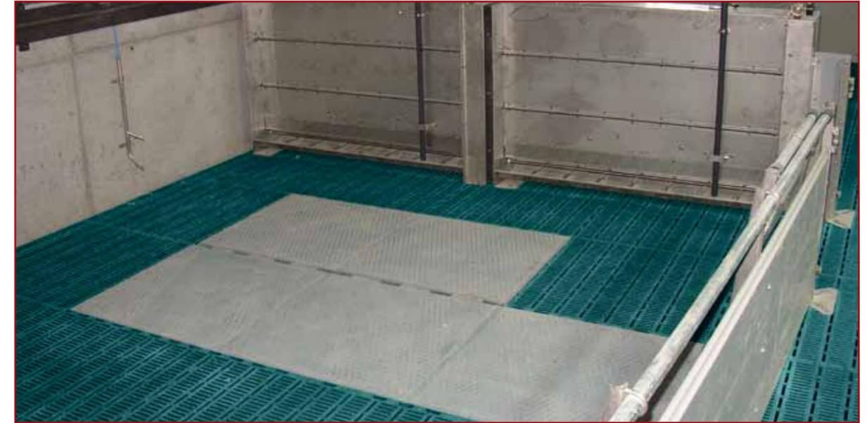
Ferkelstall mit Wand- und Bodenheizung sowie Twin-Feeder Futterautomat
