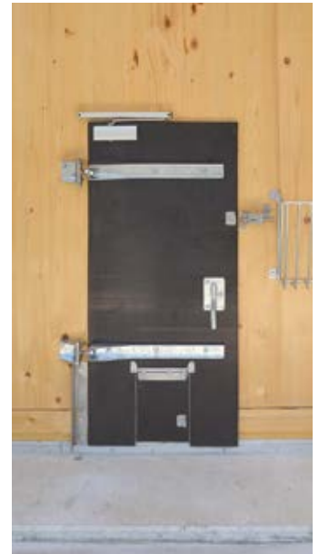
Auslauftüren niedrig mit Ferkelklappe und Einzelausgangsverriegelung
