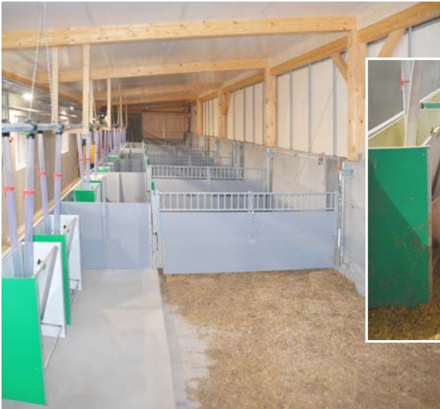
Innenansichten mit Bedientreibgang, erhöhtem Fressplatz, Strohliegebereich mit Sichtschutztrenngitter
