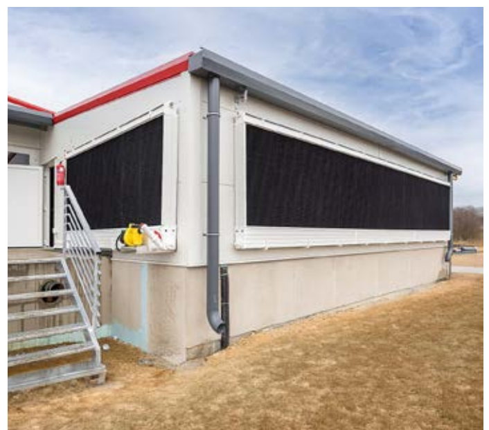
Das VERDUNSTUNGSKÜHLUNGSPAD wird in Systemen verwendet bei denen ein hoher Wirkungsgrad der Kühlung erforderlich ist
