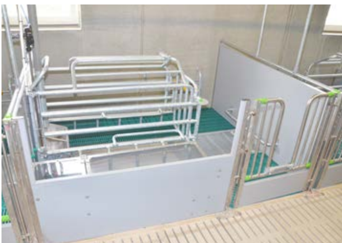
Seitlicher Eintrieb mit Durchstiegstür sorgt für einen sehr vereinfachten Arbeitsablauf
