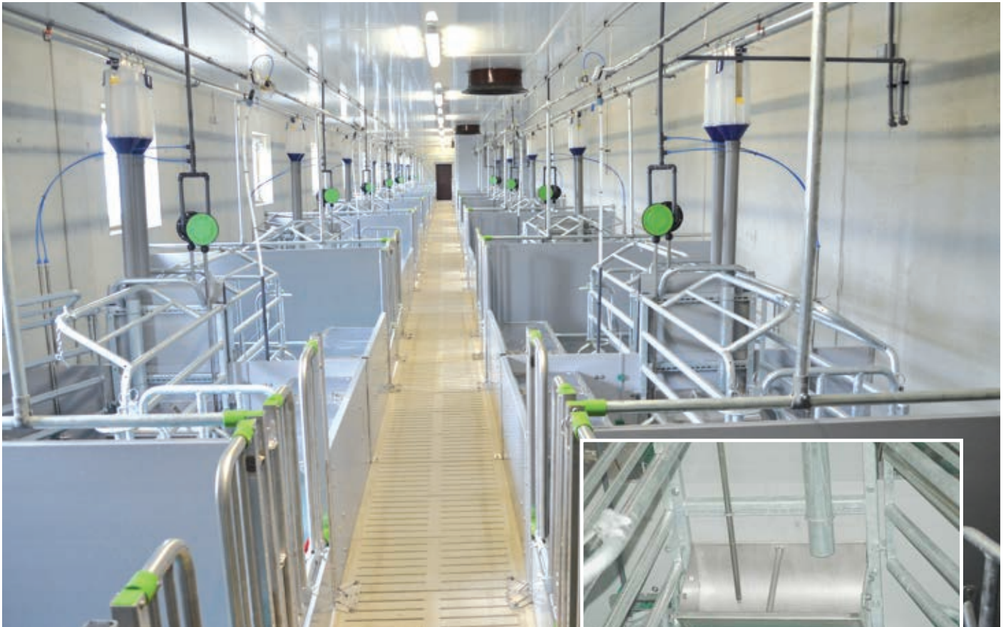
Referenzbetrieb in Niederösterreich mit Bediengang Unterflurzuluft. Die Zuluft kommt 365 Tage im Jahr über konstant gleichmäßig angenehm für die Muttersau in den Stallbereich.
